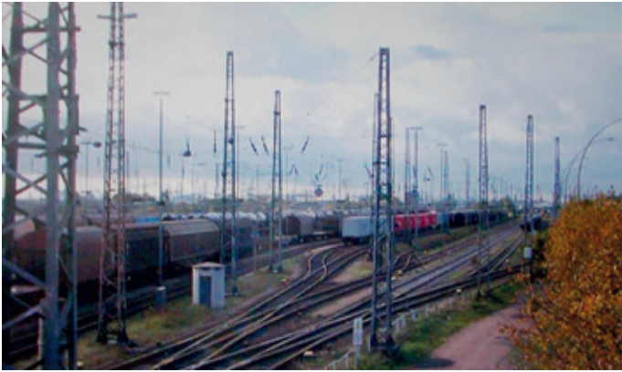
Bahnhof „Alte Süderelbe“ in Waltershof
