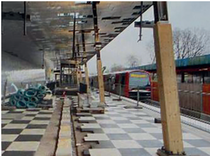
Der noch nicht ganz fertiggestellte nördliche Bahnsteig Sengelmannstraße, rechts von der U-Bahn der südliche Bahnsteig, der nun abgebrochen und dann neu aufgebaut wird.
